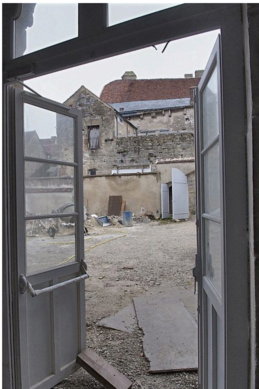
Vue de la cour pendant les travaux.
