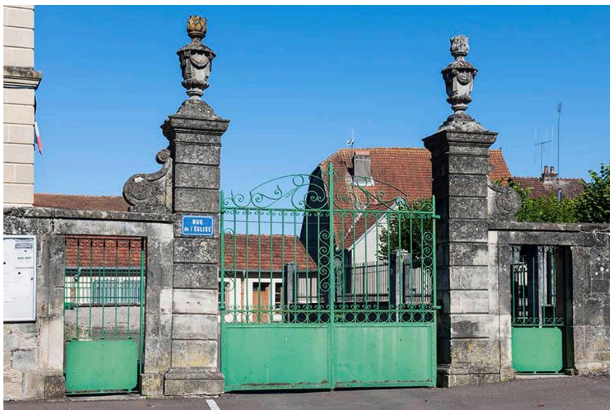
Portail d'entrée de la mairie.
