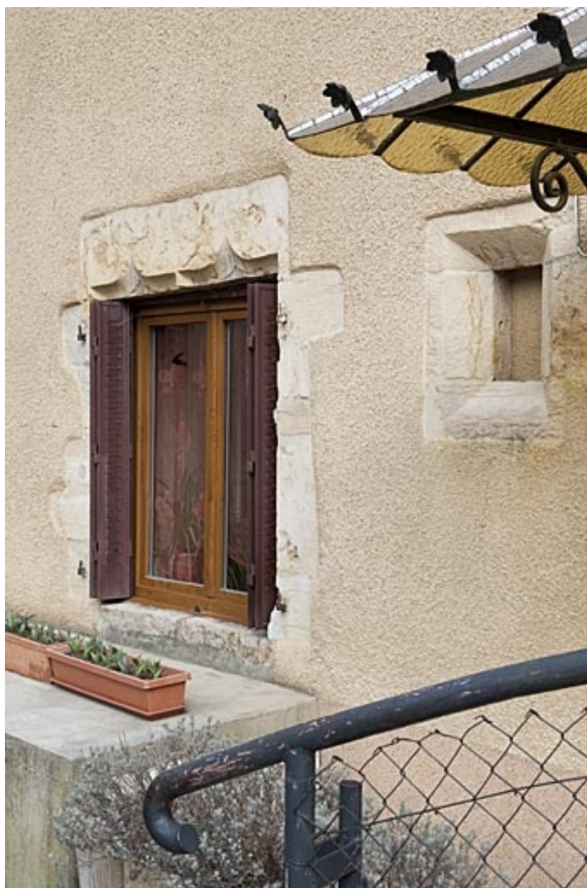
Fenêtre à linteau en arc en accolade de la maison au 12 Grande Rue (2010 AL 47).
