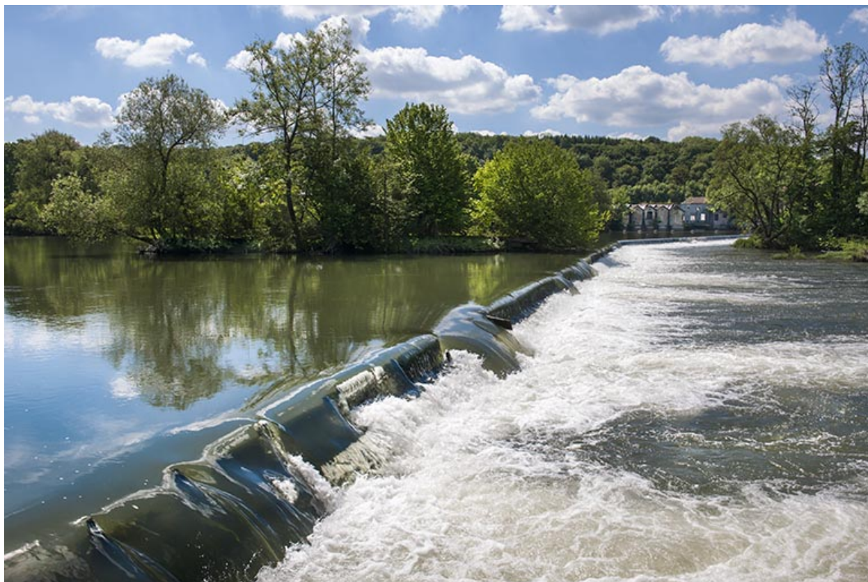
Le barrage depuis la rive droite.
