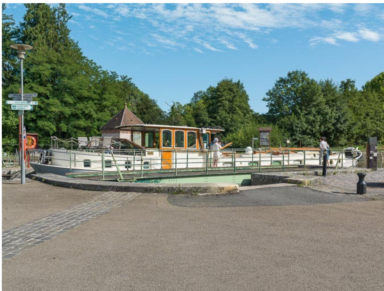
Pont au passage d'un bateau.
