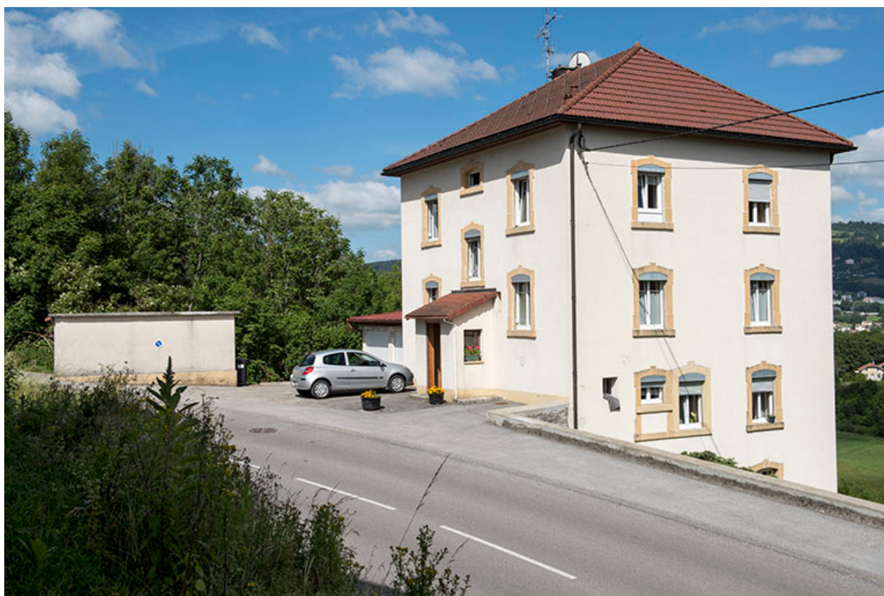
Façades antérieure et latérale droite.
