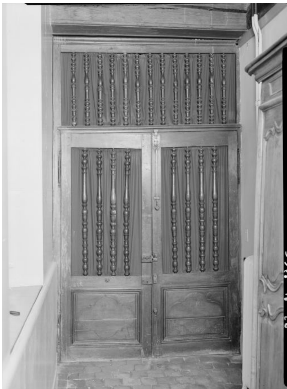
Porte au fond du couloir.
