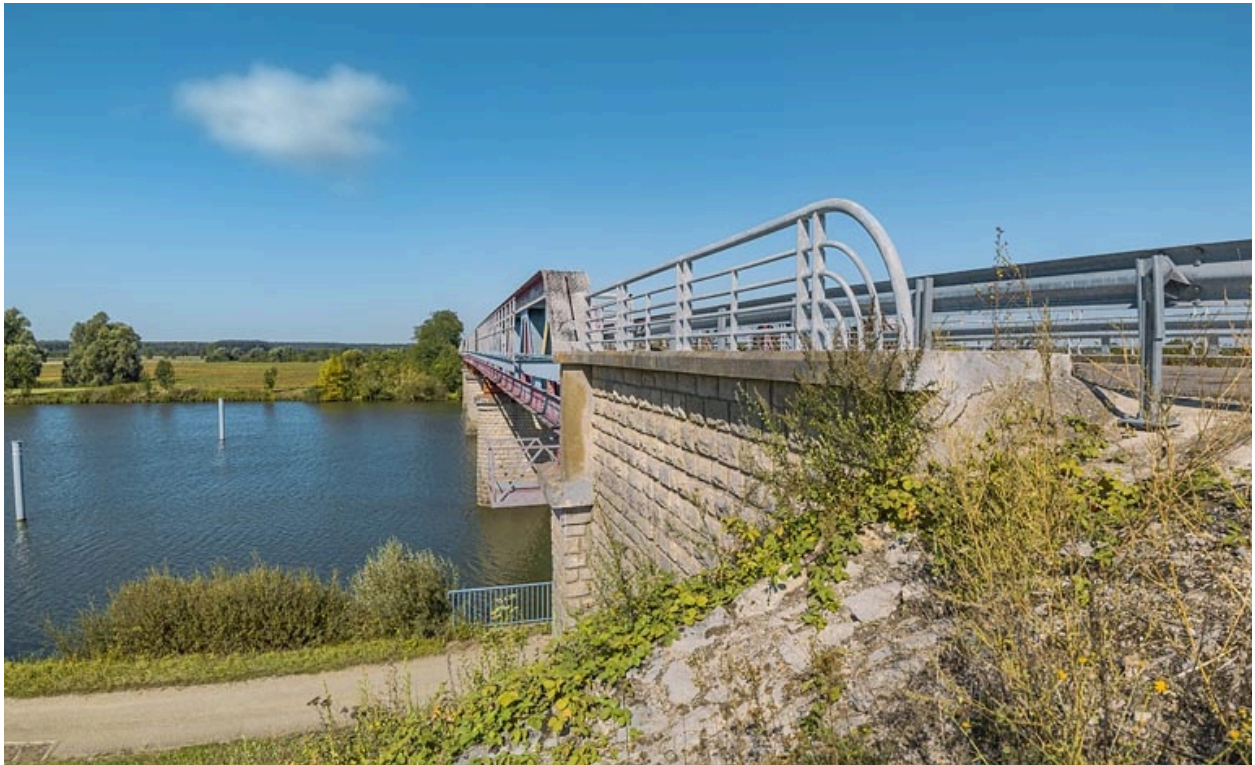
Vue d'ensemble du pont.
