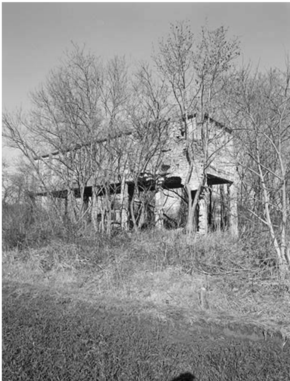
Réservoir industriel (bac à saumure).
