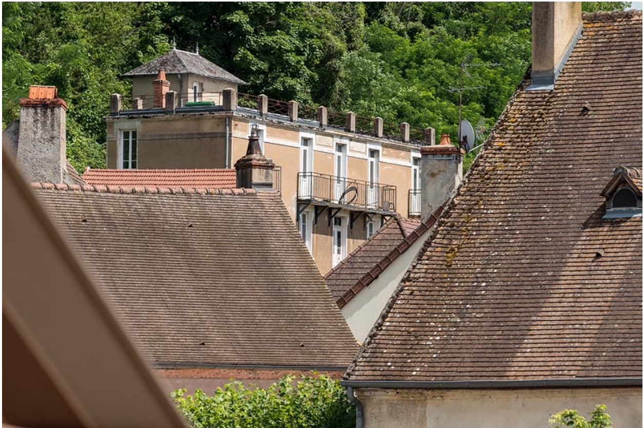
Façade de l'extension ("annexe").
