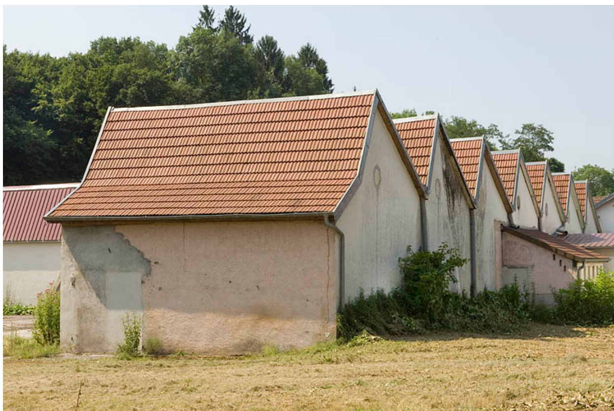
Atelier de fabrication couvert de sheds.
