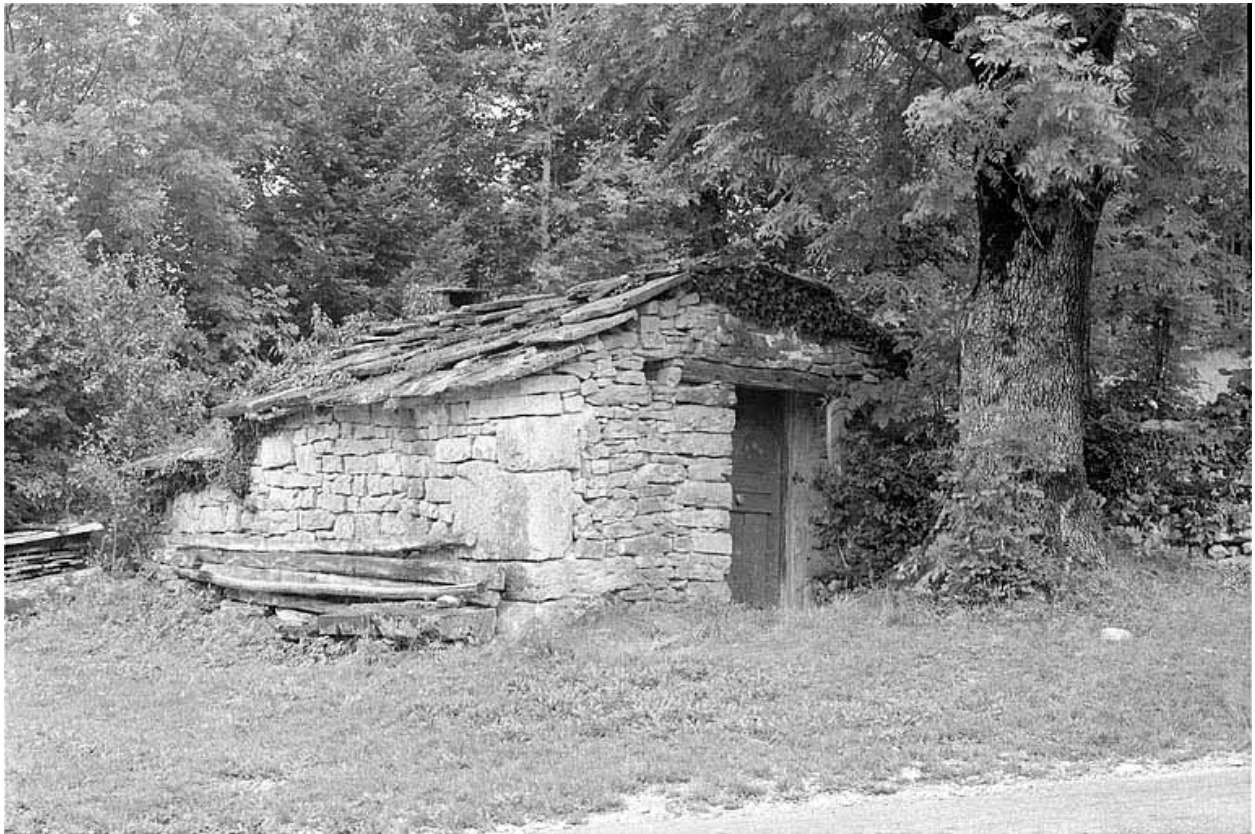
Fornil couvert en pierres calcaires.
