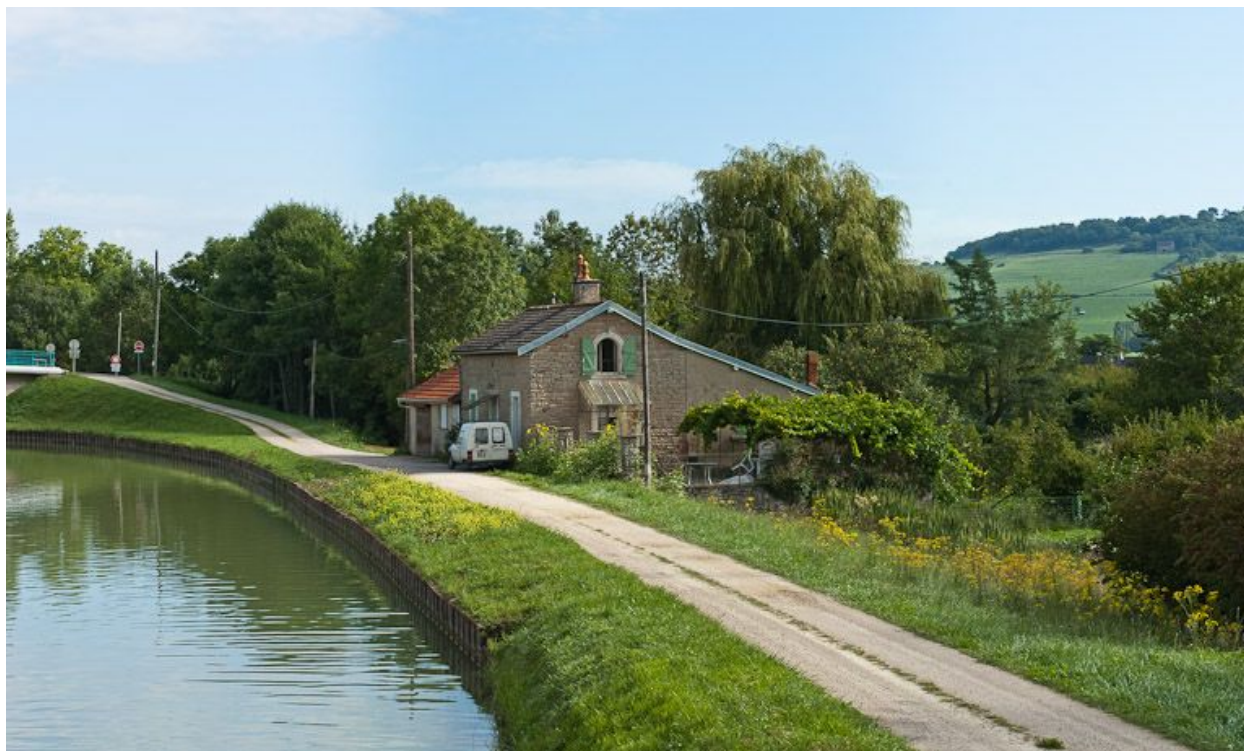
Vue de la maison de garde.
