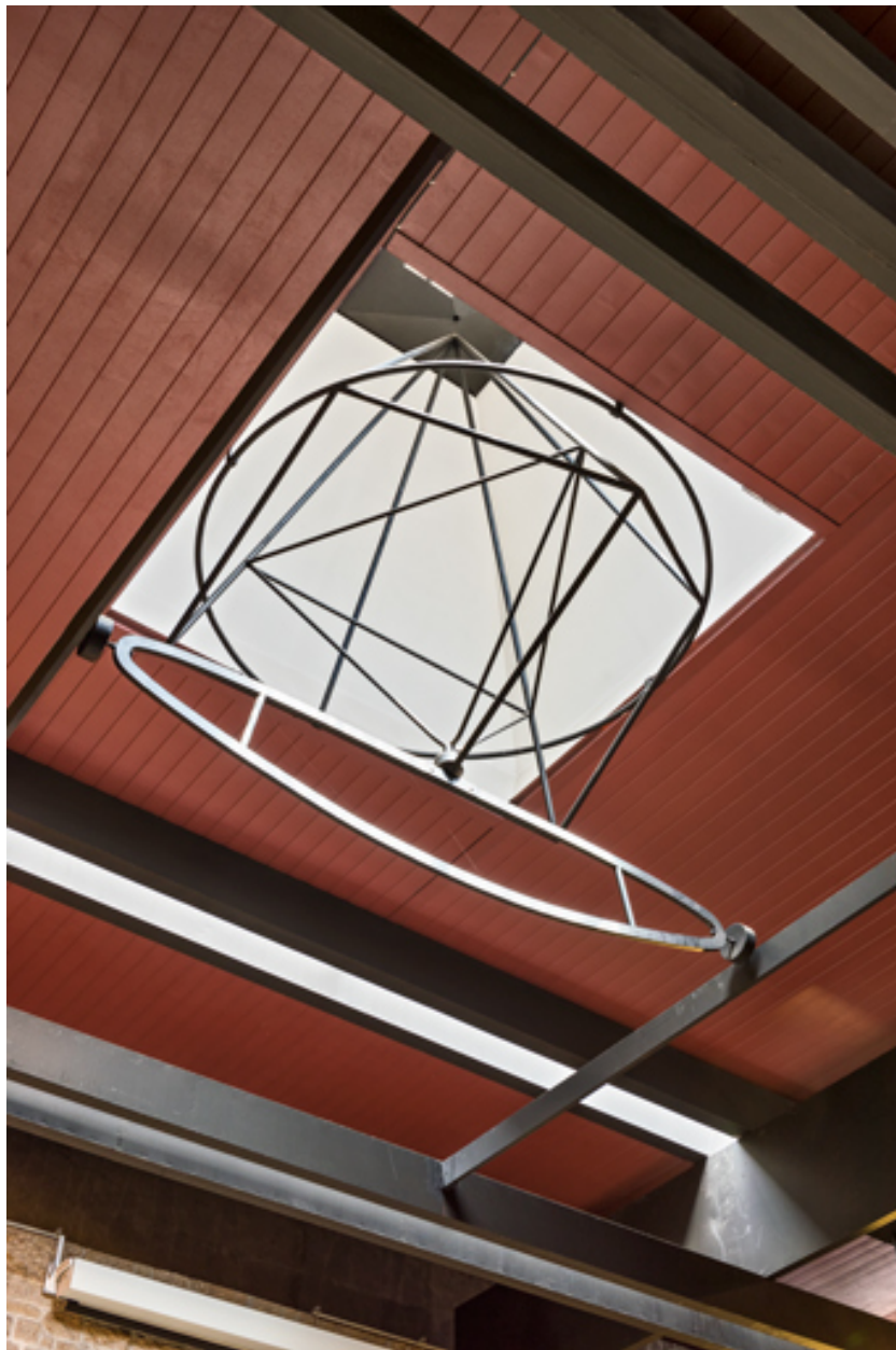
Ouverture zénithale et sa structure métallique au-dessus du chœur.
