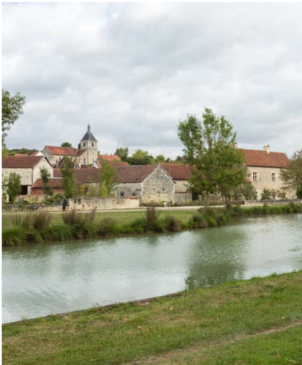
L'église vue du chemin de halage.
