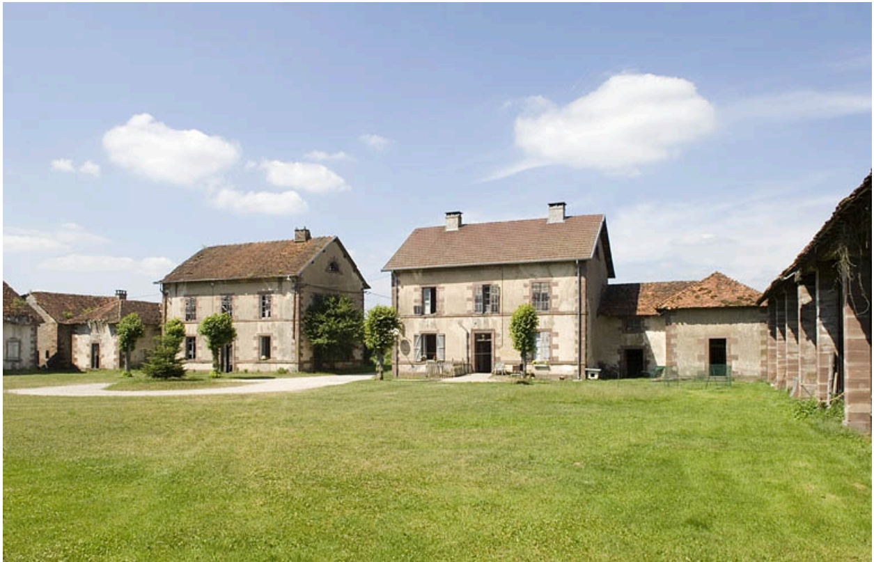
Vue d'ensemble depuis le sud de la cour.
