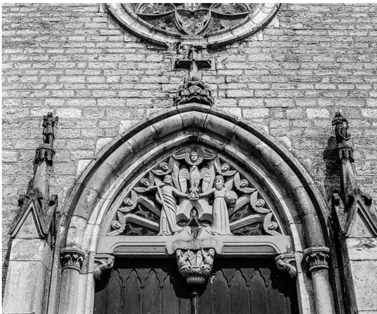
Extérieur : portail, façade antérieure, détail.
