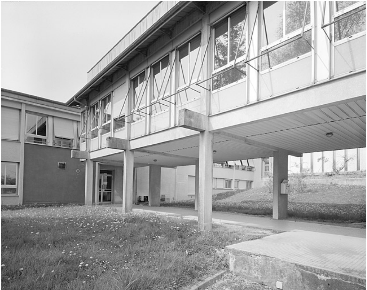
Partie sud : laboratoire d'essais et bureaux, galerie couverte de 1980-1981.
