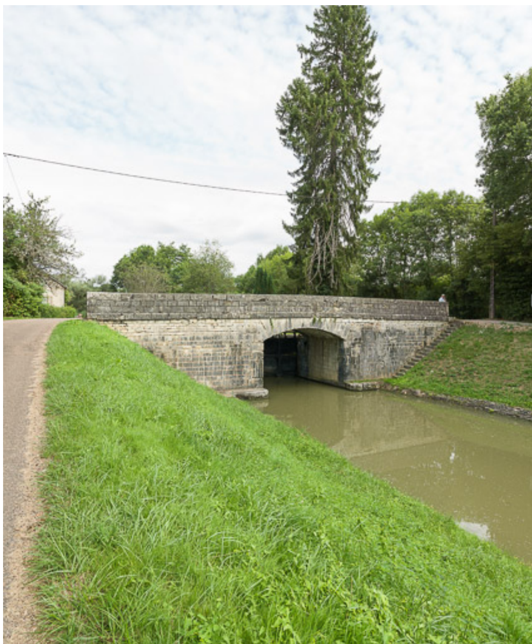
Vue d'ensemble du pont.
