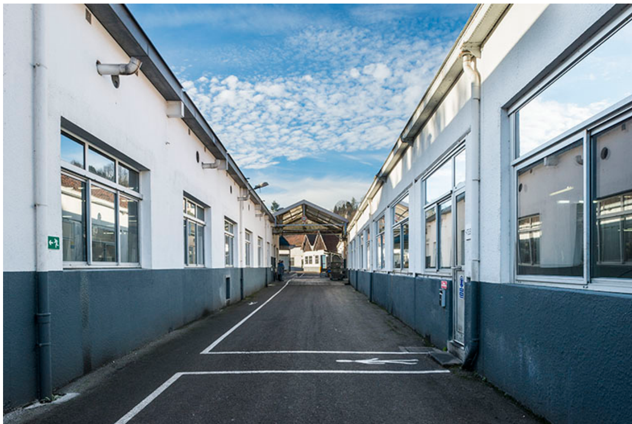
Passage entre deux ateliers. Vue depuis l'ouest.
