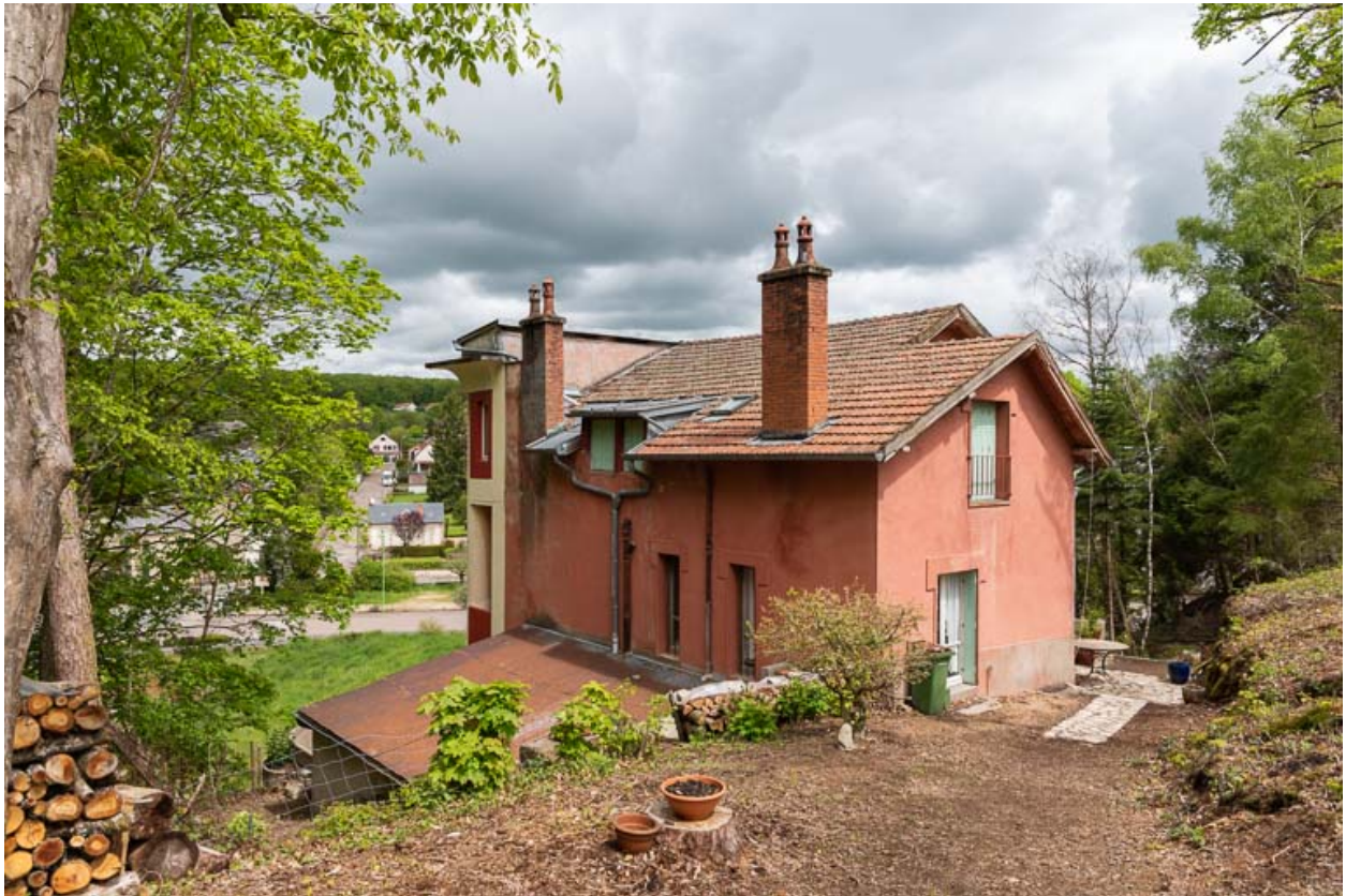
Façade sud, vue de trois quarts.
