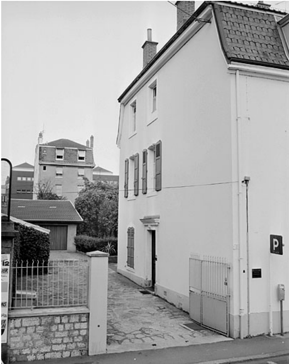
Façade latérale gauche du corps d'habitation.
