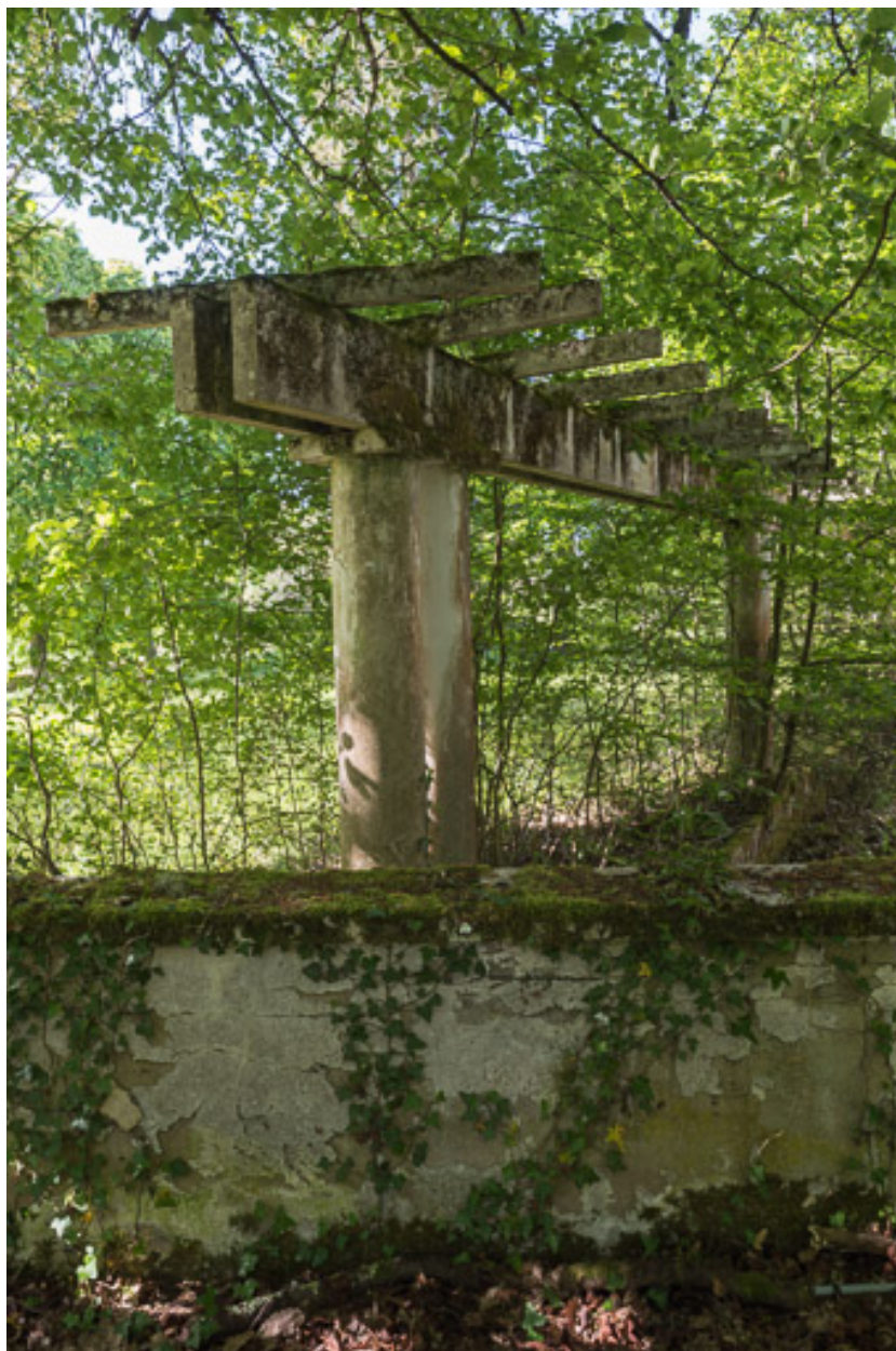
Pergola, vue depuis le nord-est, détail.
