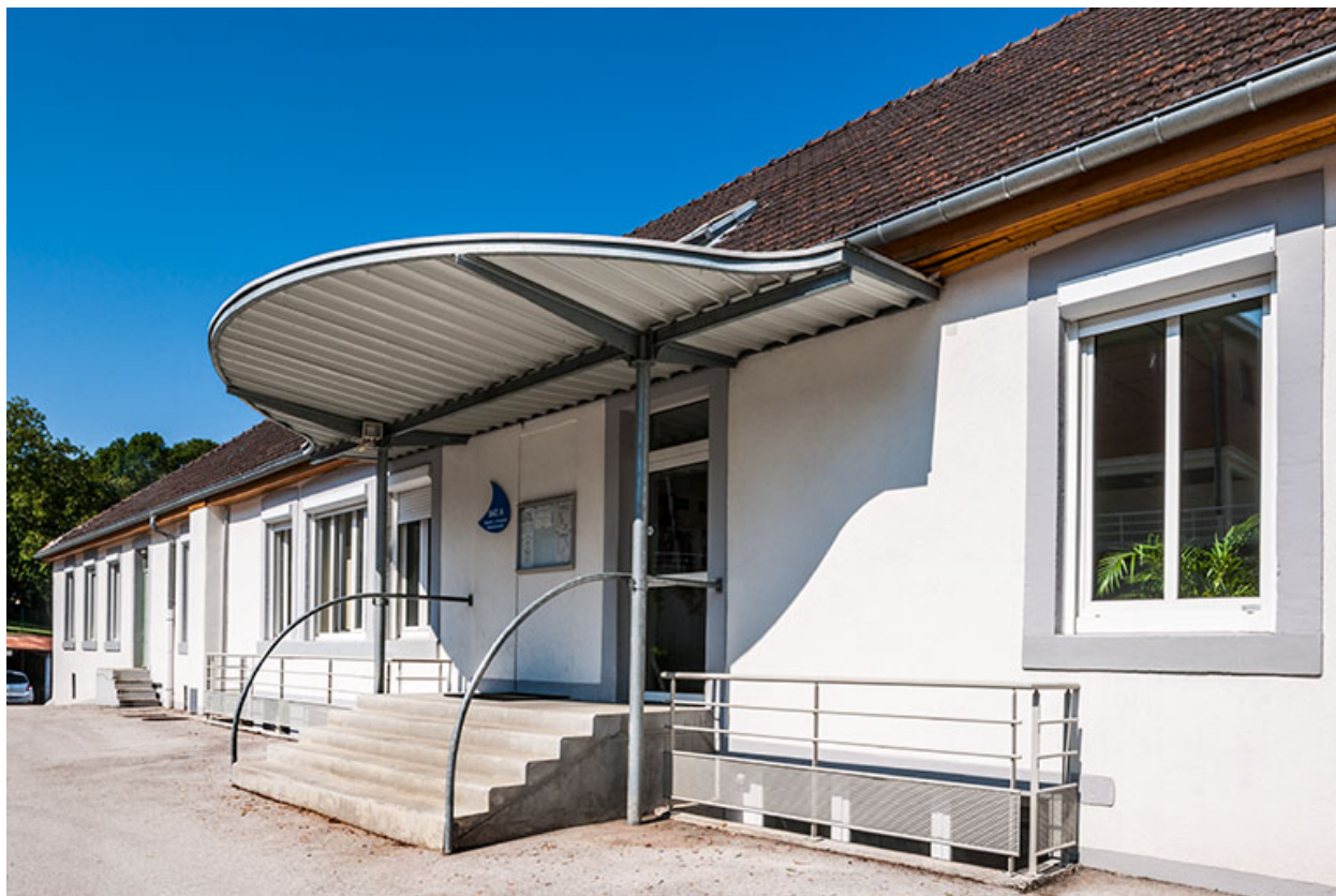
Détail de l'entrée postérieure du bâtiment d'externat.
