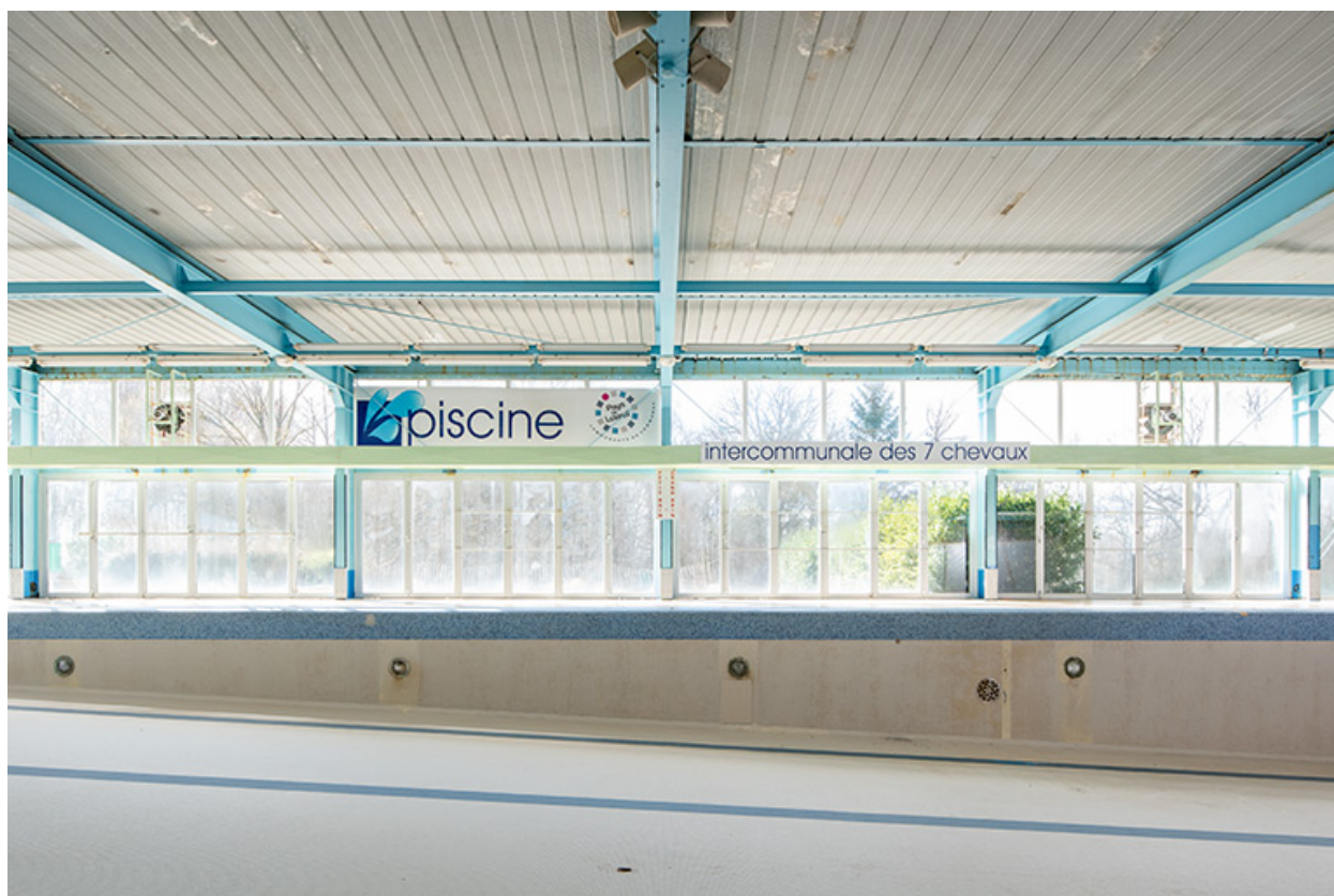
Le mur sud-ouest du bassin de la piscine.
