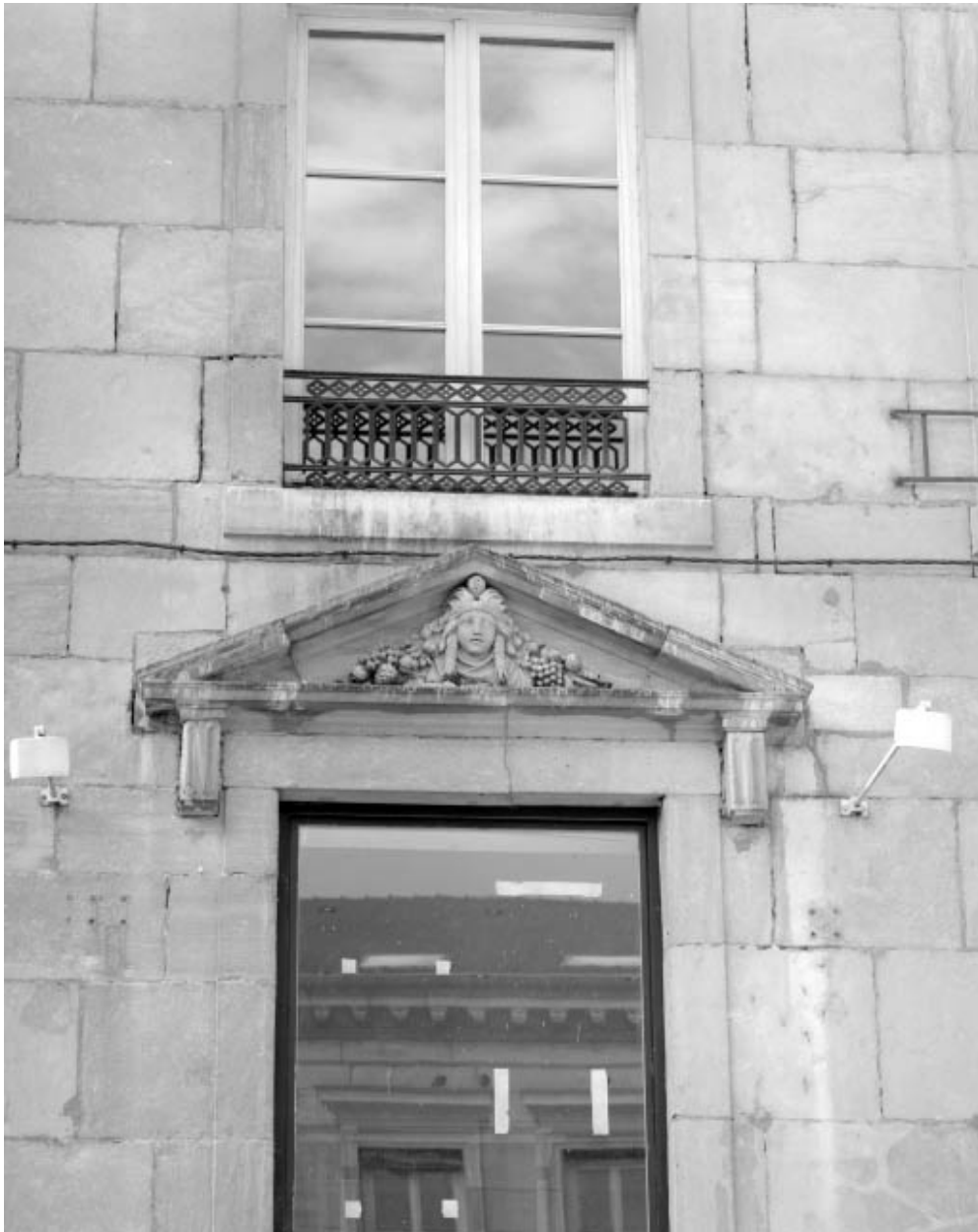
Façade sur rue, détail du fronton sur la baie centrale de la partie droite.
