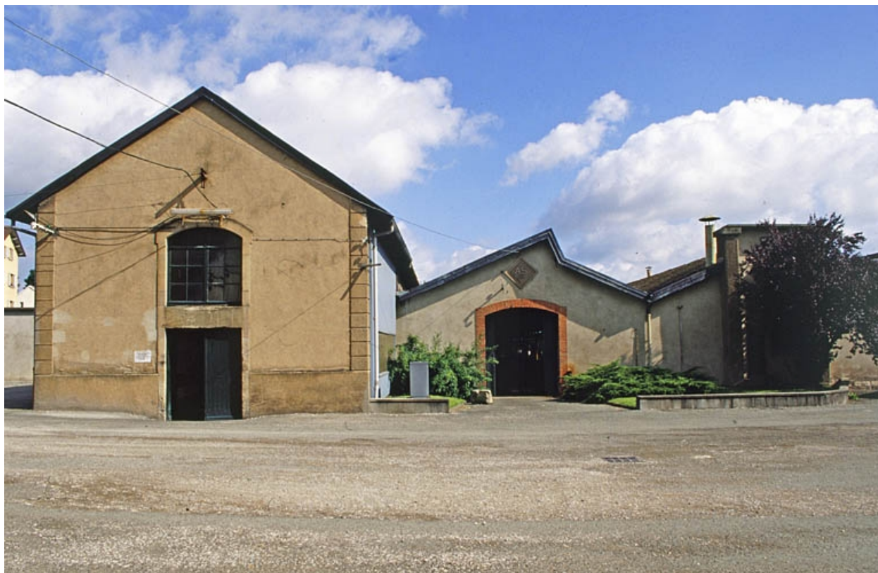
Murs-pignons des ateliers de fabrication.
