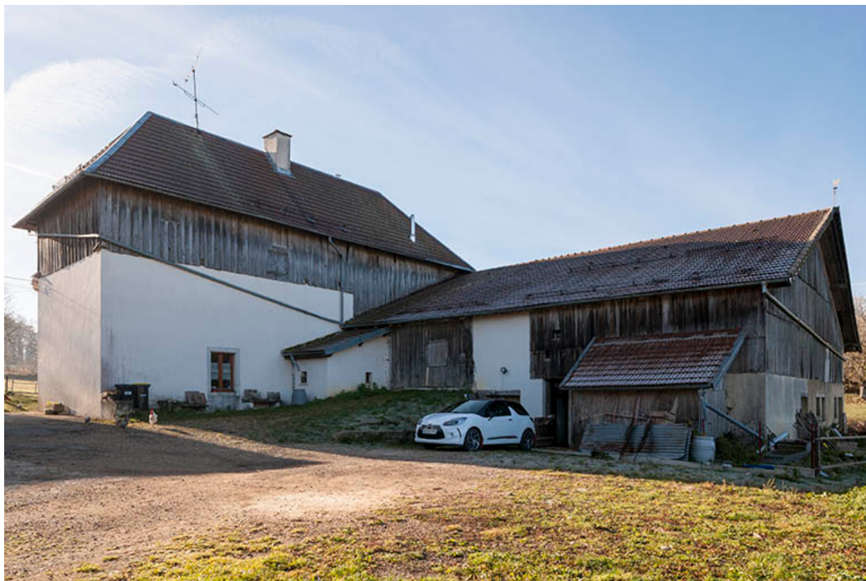
Ferme : façades nord et est.
