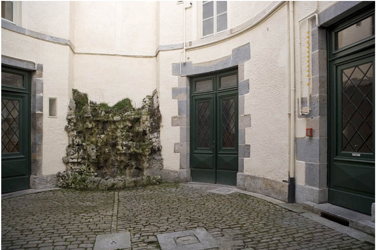
Vue du fond de la cour avec le bassin, depuis l'entrée.
