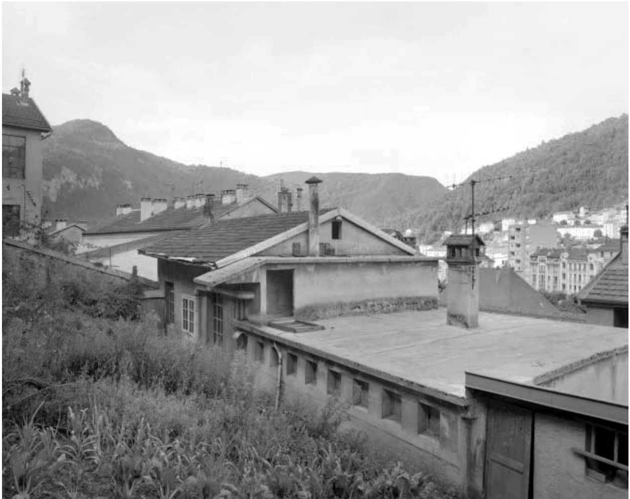
Façade postérieure des ateliers de fabrication.
