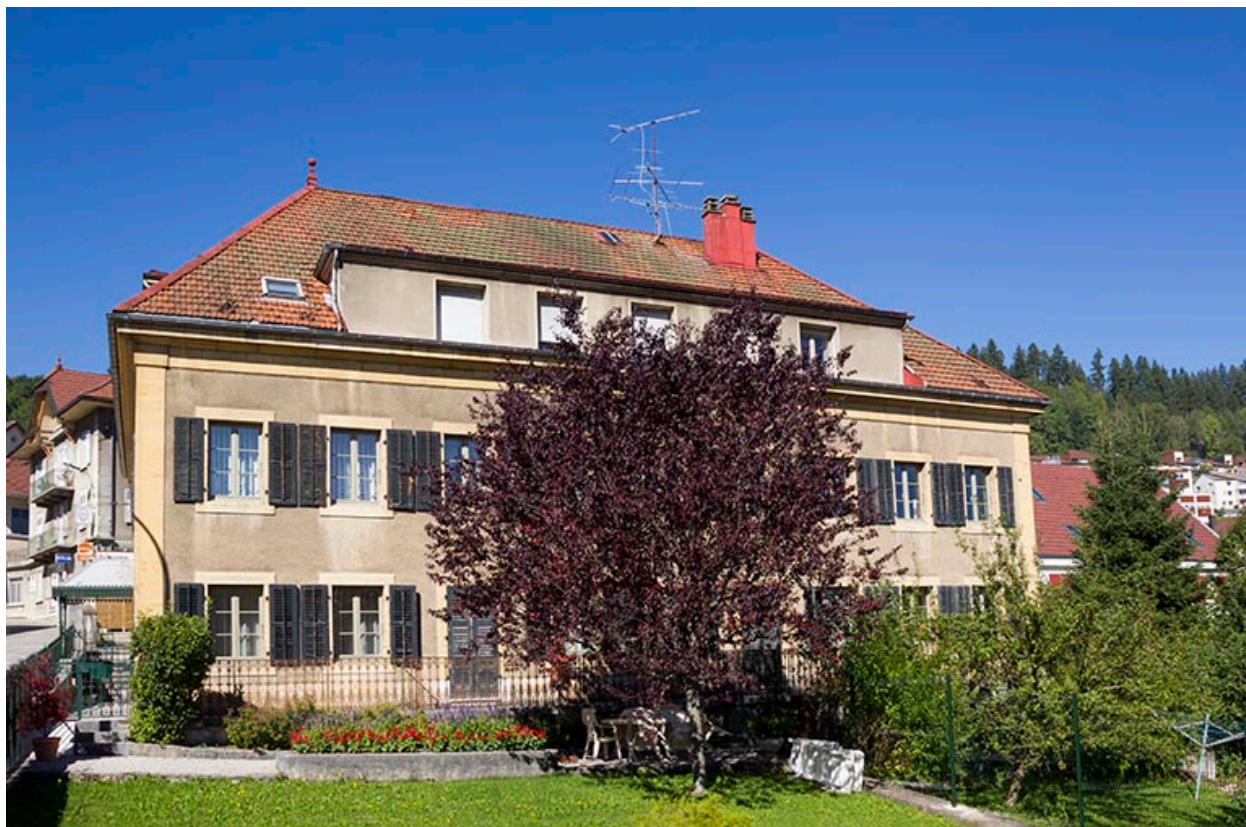
Maison : façade latérale droite.
