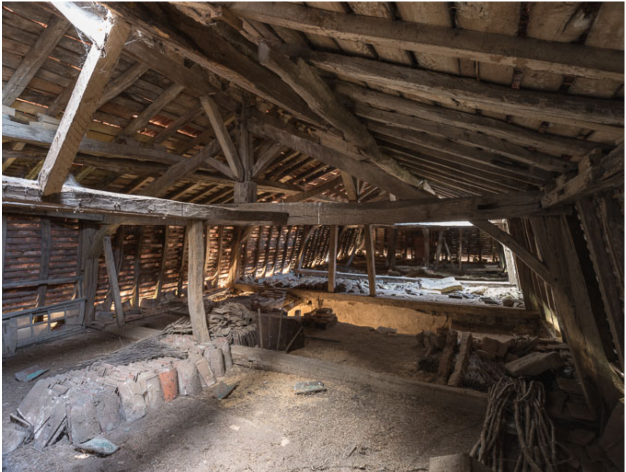
Vue de la charpente de la demeure
