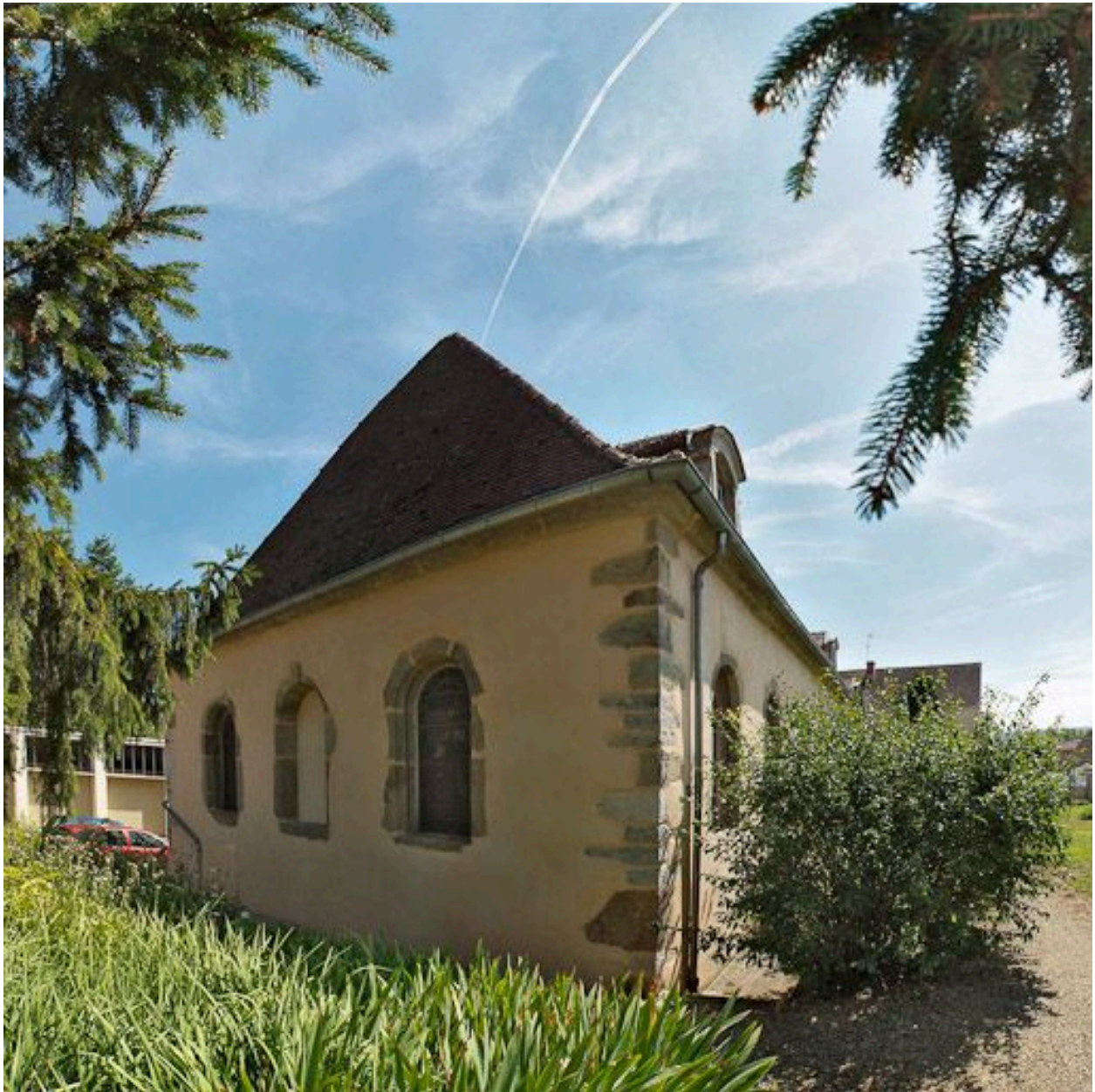
Élévation droite (ancienne chapelle).
