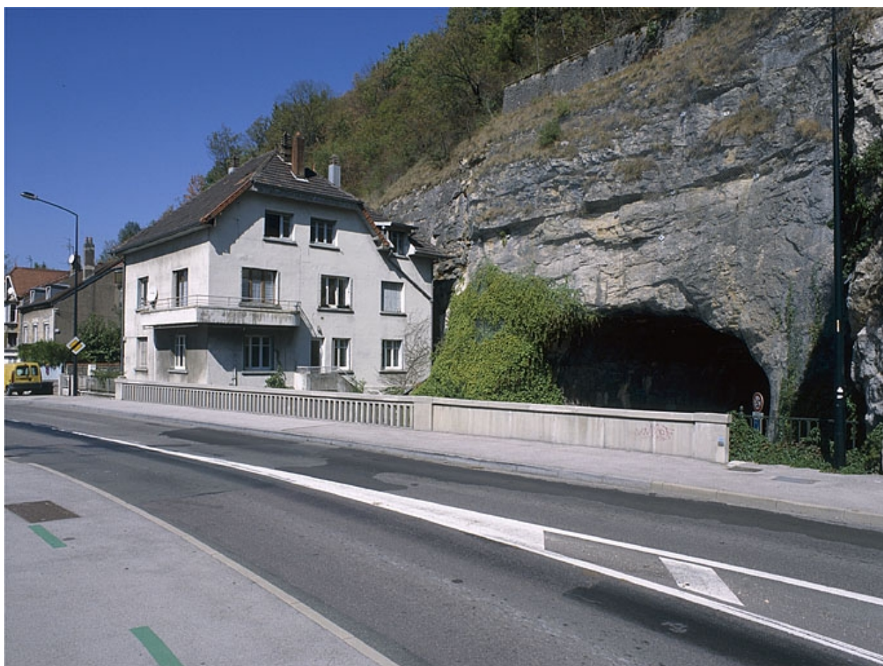
Pont routier et maison d'éclusier.
