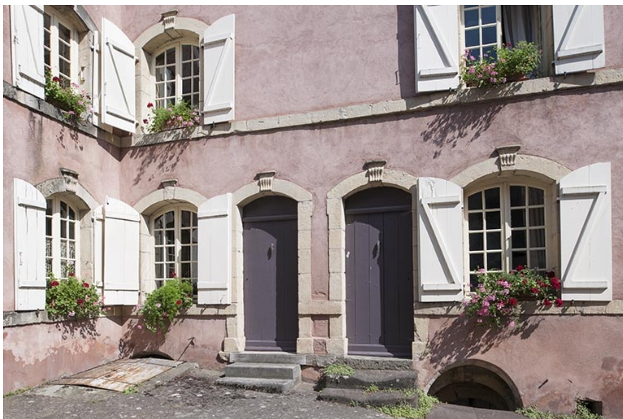
Détail de la façade postérieure, rue Thiers.
