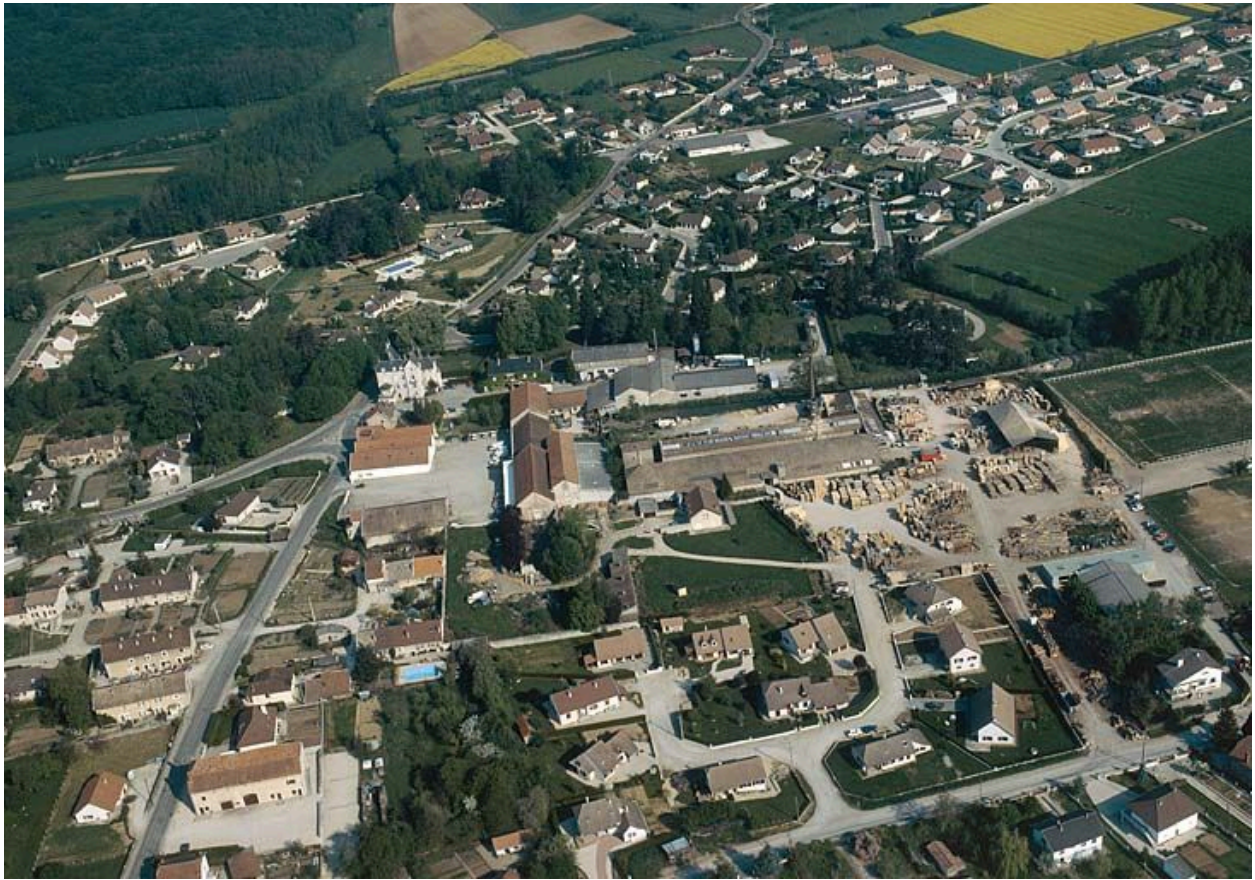
Vue aérienne de l'usine depuis le sud-est.
