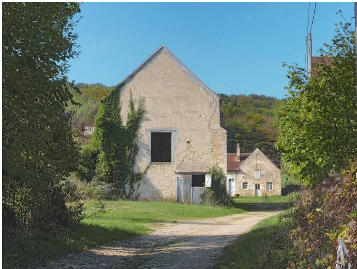
Mur postérieur de la chapelle.
