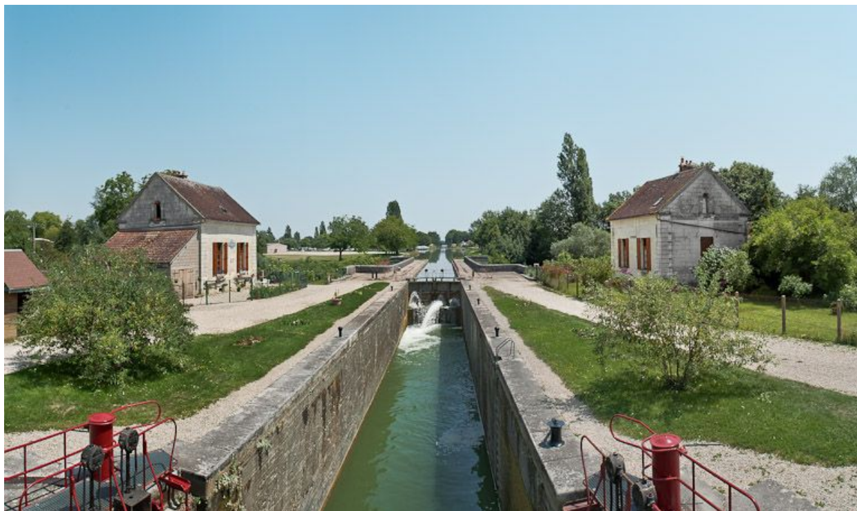
Vue d'ensemble du site d'écluse.
