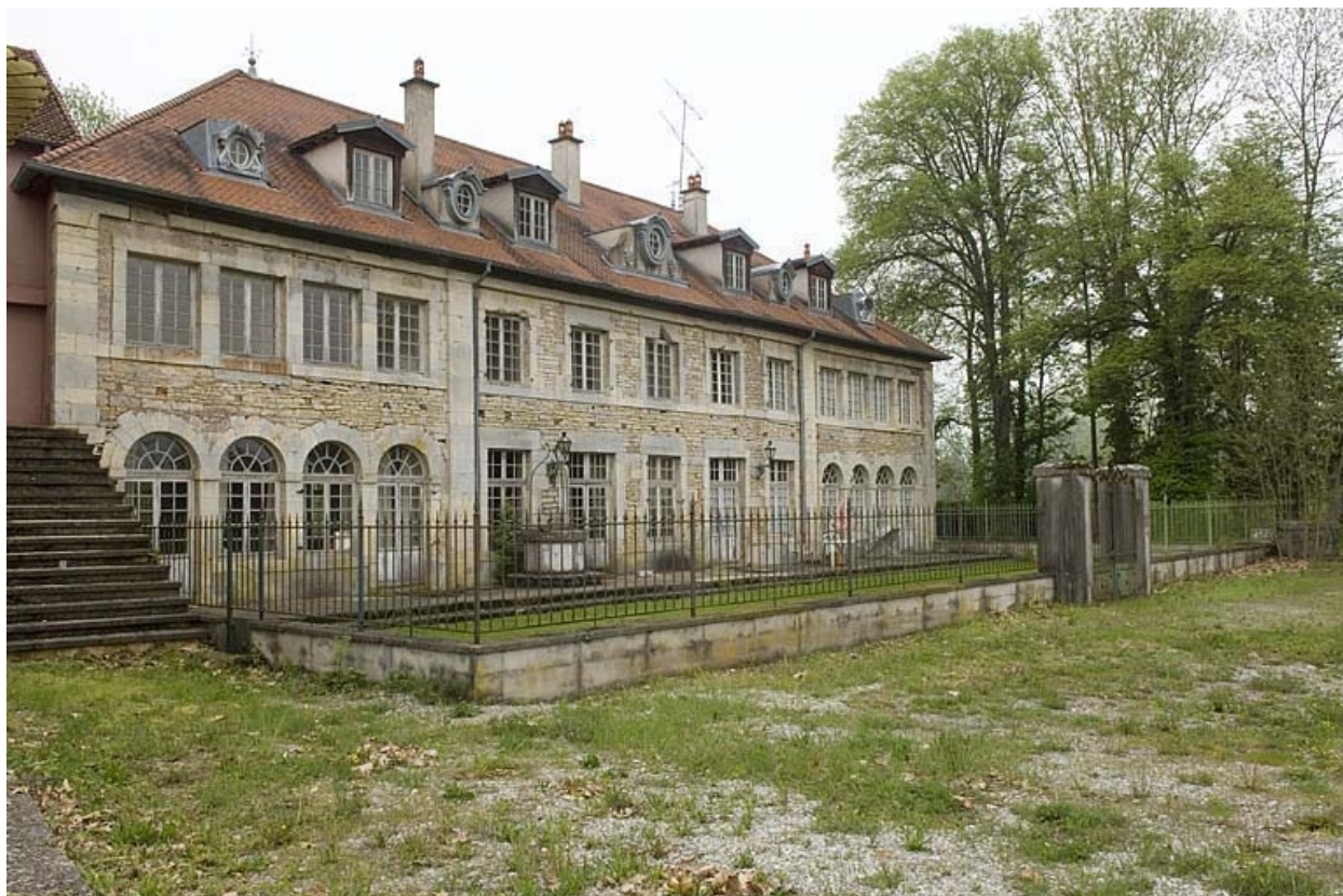
Logement patronal. Vue de trois quarts.
