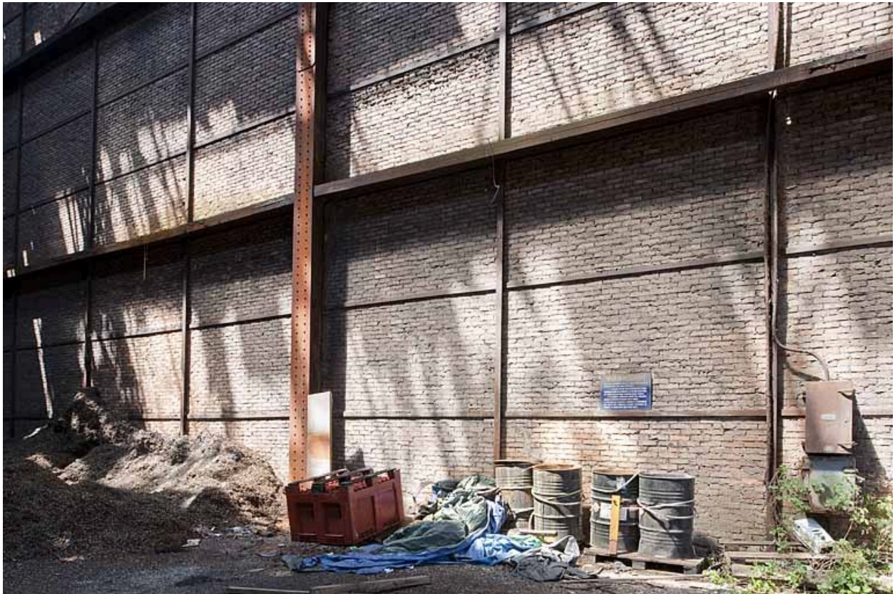
Vue intérieure du bâtiment du gazogène. Mur nord.
