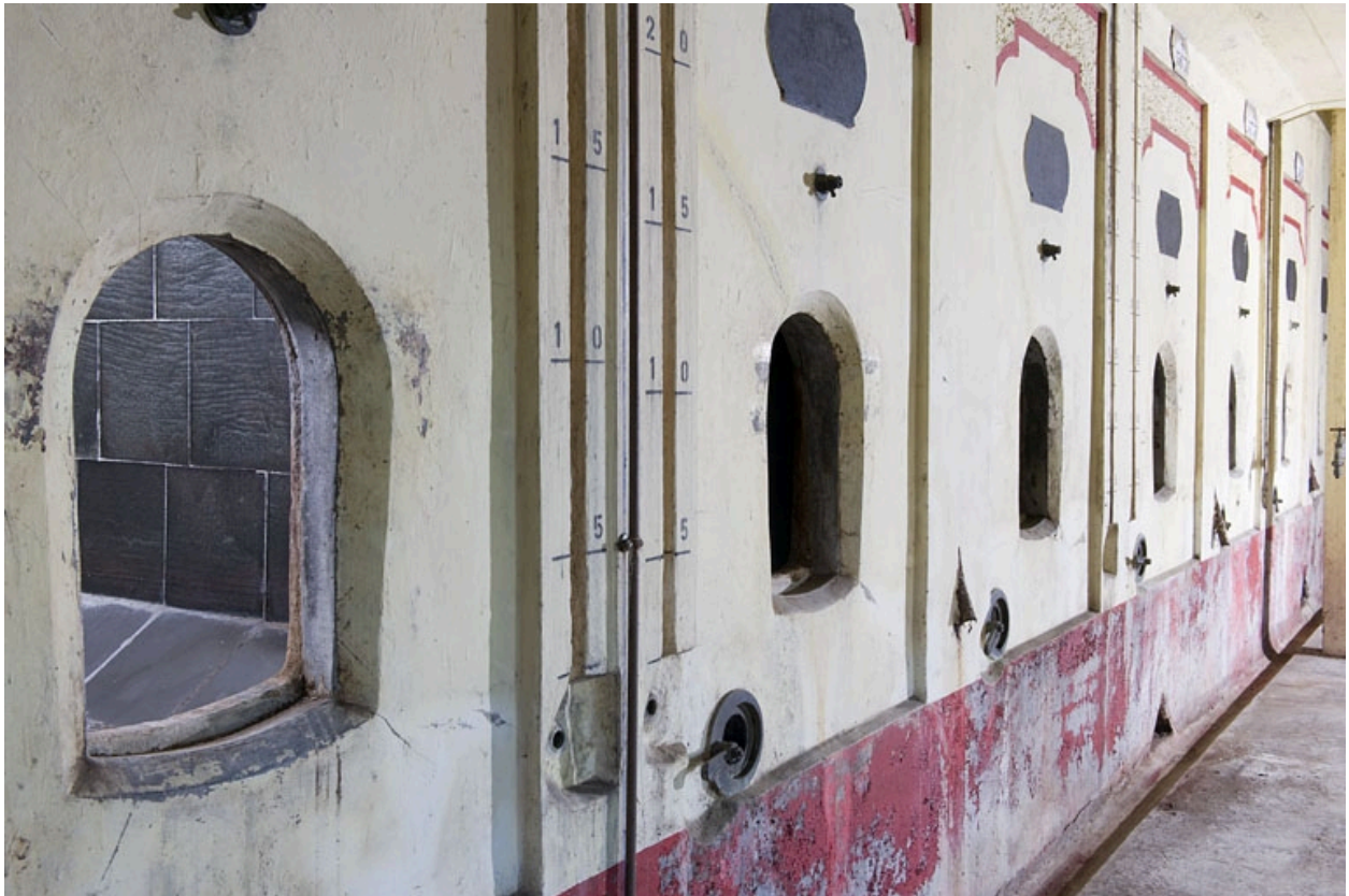
Intérieur de l'entrepôt : enfilade des cuves du premier niveau.
