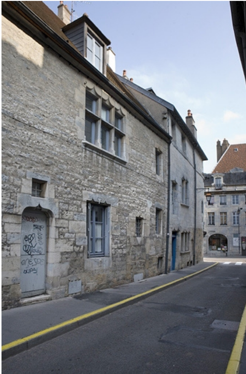
Façade latérale gauche : vue partielle.
