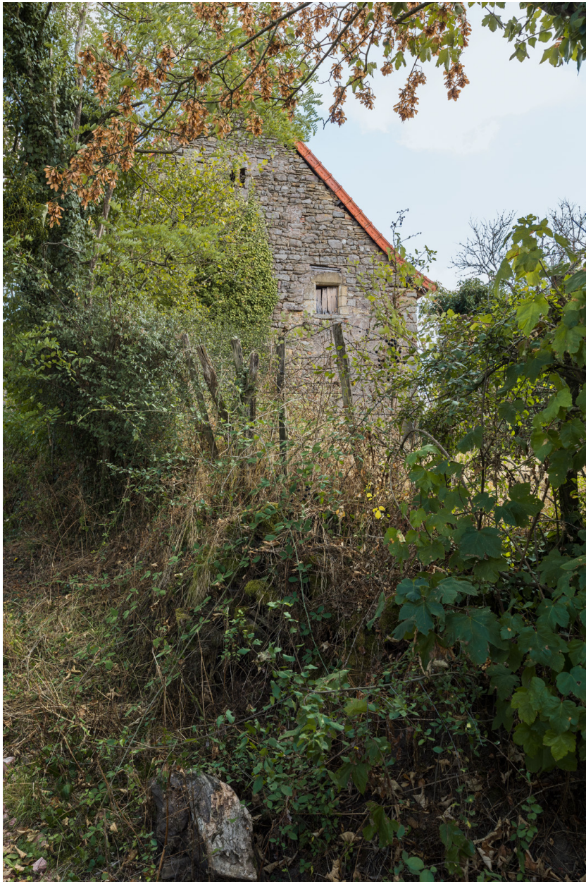
Pignon ouest de la partie agricole.
