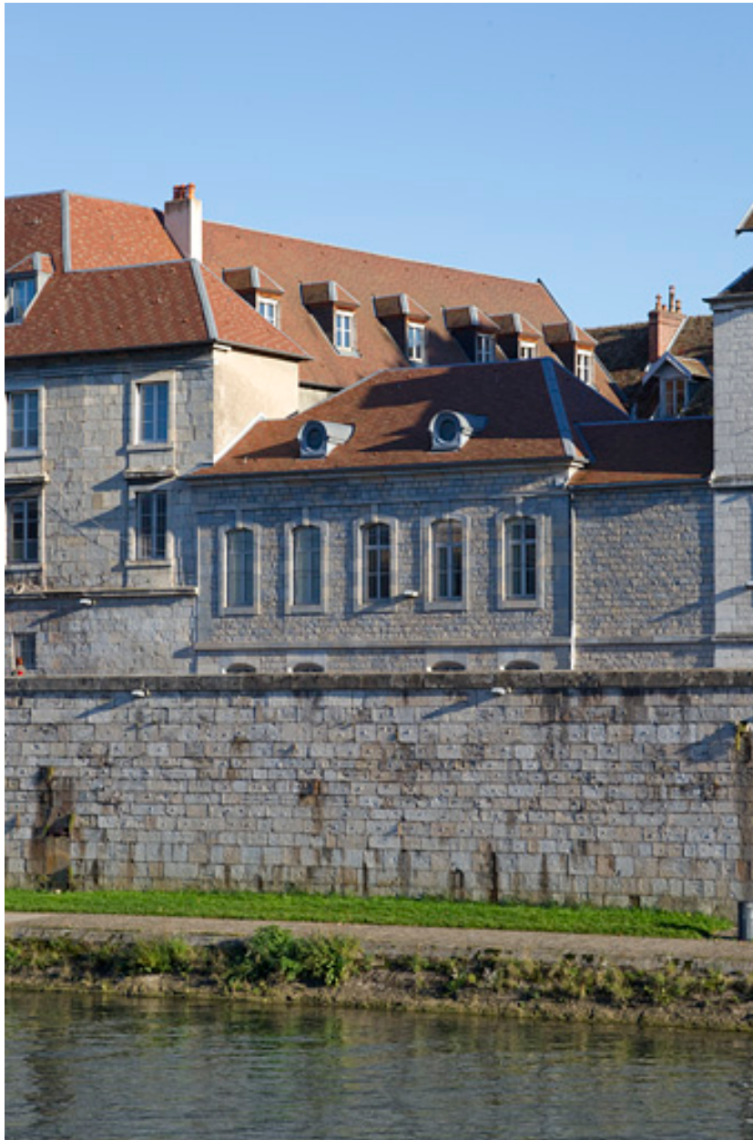
Façade postérieure de l'infirmerie.
