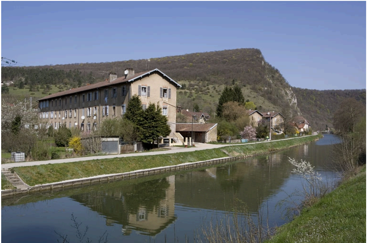
Logement d'ouvriers (10 à 16 rue des Ecoles). Vue de trois quarts.
