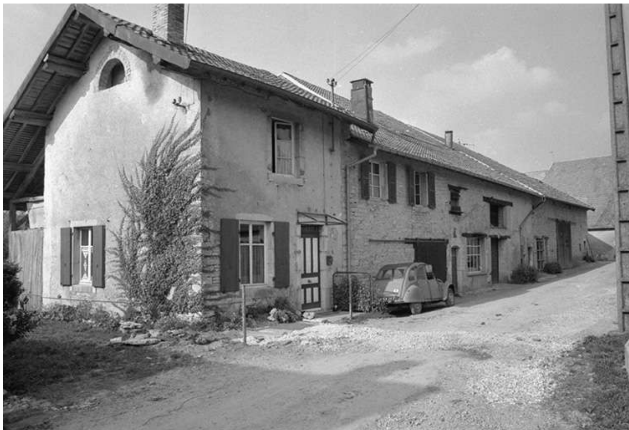
Maison située rue de l'Eglise
