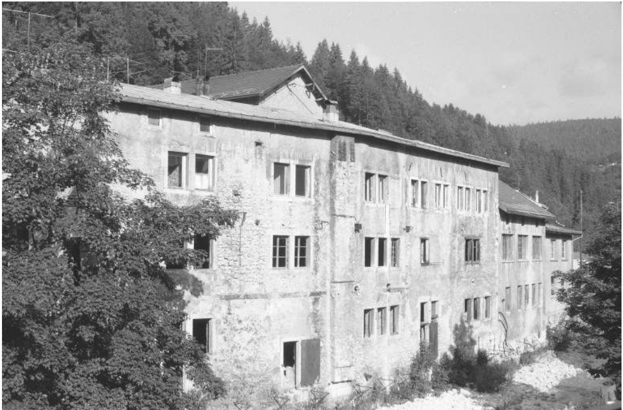
Façade sur la Bienne depuis l'est (amont).
