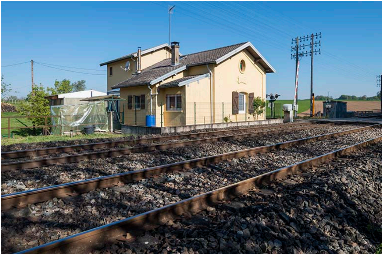
Vue depuis le Sud.
