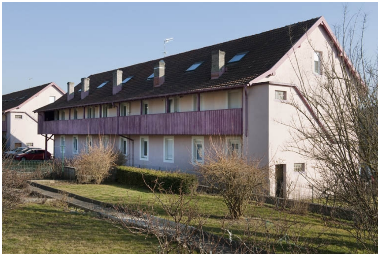
Immeuble d'habitation vu de trois quarts arrière..
