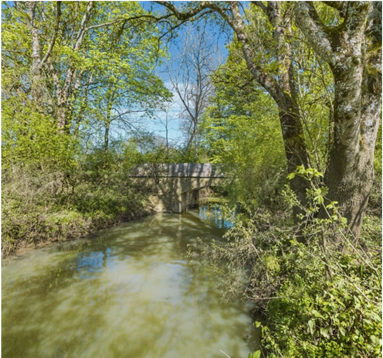
Vue d'ensemble du pont.
